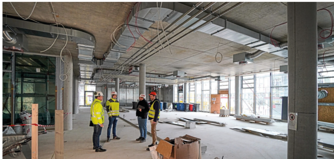
Im Erdgeschoss entstehen Schulungs- und Veranstaltungsräume und eine Cafeteria.
