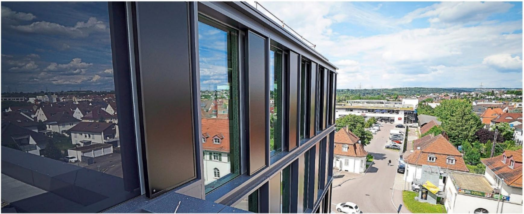
An der Fassade ist ebenfalls Photovoltaik installiert. Sie steckt in den schwarzen Wandelementen und ist rings um das Gebäude angebracht.
